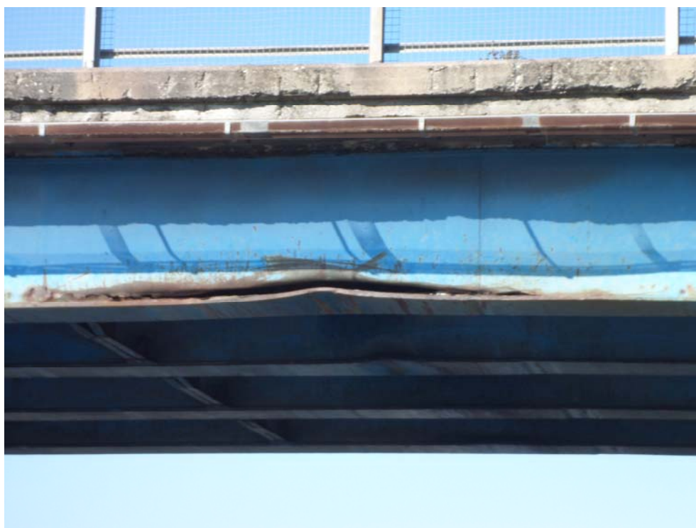
Urto di un cavalcavia in acciaio
