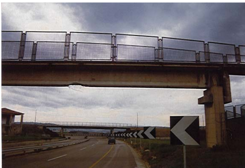
Urto di un cavalcavia in calcestruzzo
